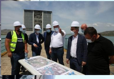
წყალმომარაგების სისტემის მშენებლობა დედოფლისწყაროს მუნიციპალიტეტში, საქართველო (2021 წ. მაისი) (წყარო: შპს „საქართველოს გაერთიანებული წყალმომარაგების კომპანიის Facebook გვერდი).
