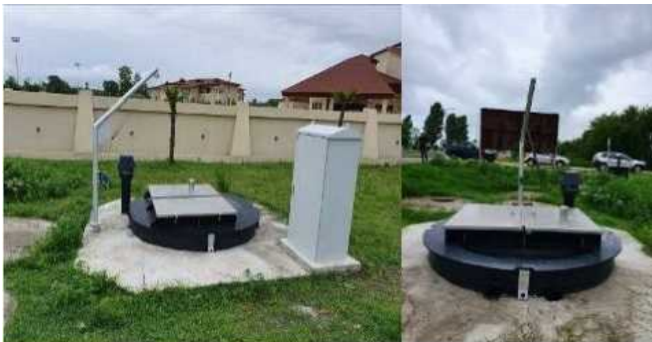
სურათი 2: აღდგენითი აქტივობები ანაკლია - 33-ე სატუმბო სადგური სამშენებლო სამუშაოებამდე
